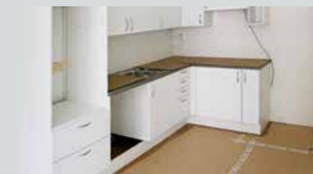
Tildekking for å unngå skader.
