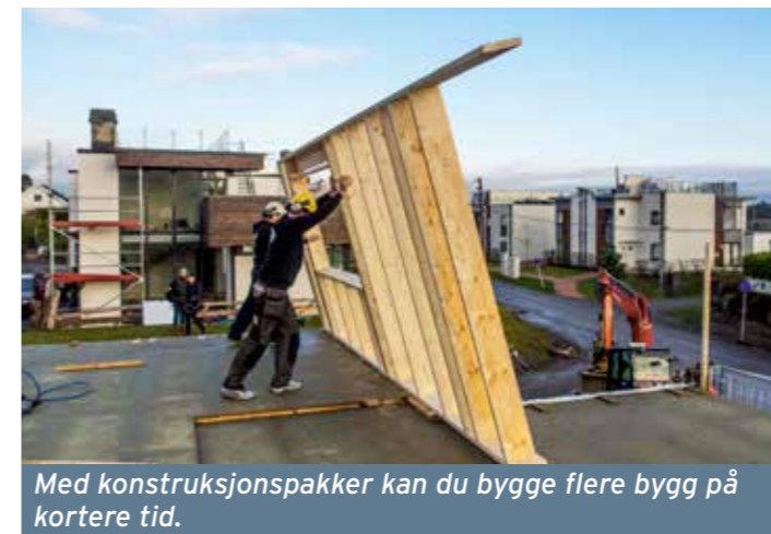
Alt er kappet feilfritt og godt merket slik at det er enkelt å montere.
