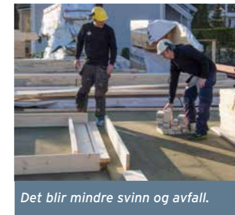
Bindingsverket er pakket, merket og stablet i riktig rekkefølge.
