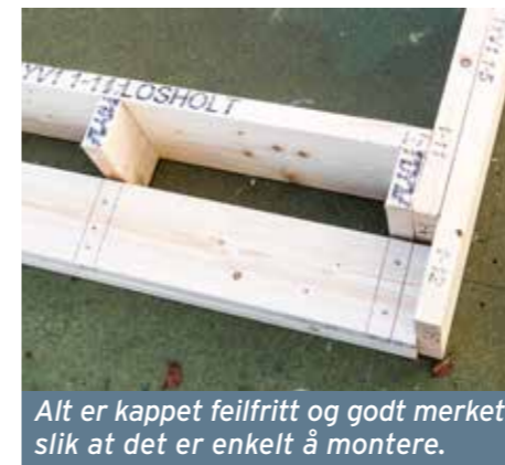
Bindingsverket er pakket, merket og stablet i riktig rekkefølge.
