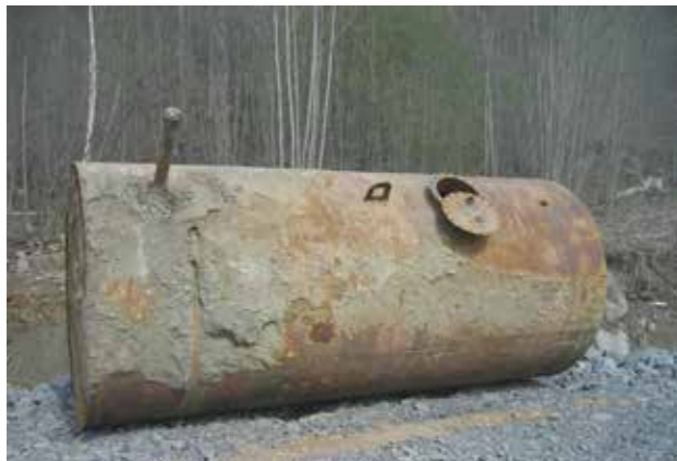
Nedgravd oljetank. Foto: Bolig Enøk AS
