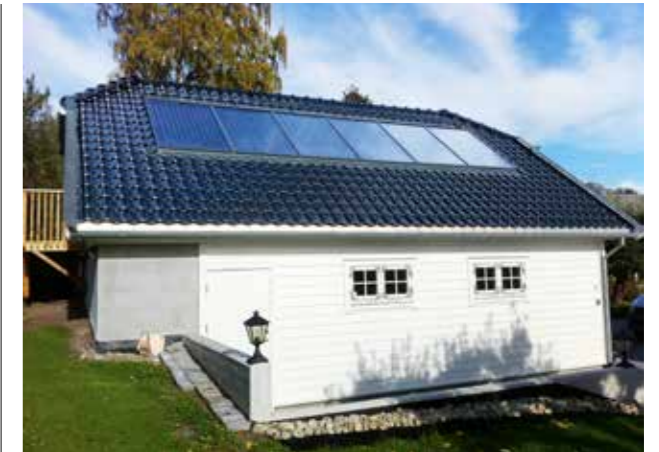
Solvarmeanlegg integrert i garasjetak.
