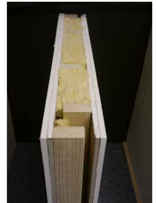
Delevegg med 100 mm mineralull
