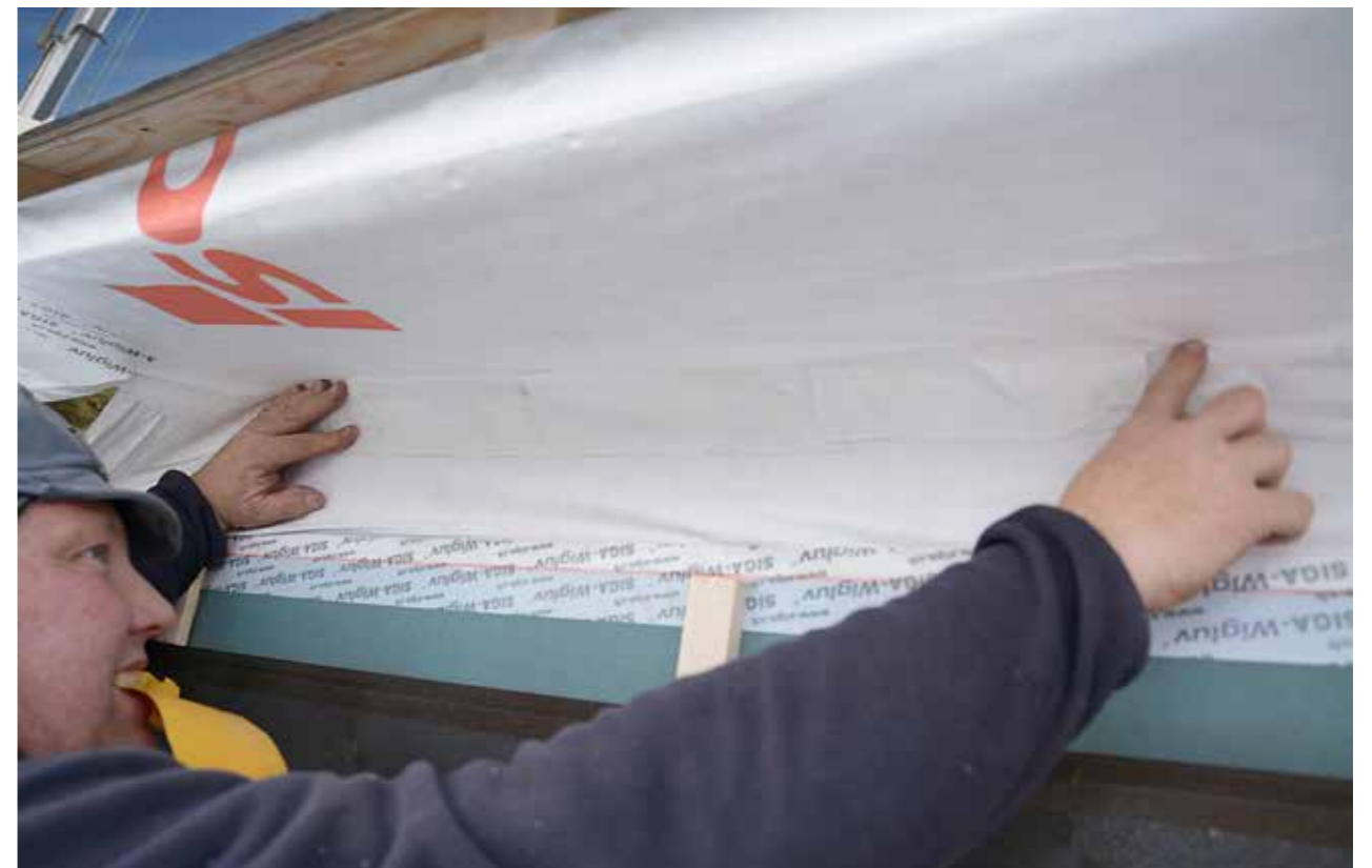
Vindsperrereduk er påmontert veggelement og strekkes rundt gesims og klemmes mellom spikerslag og forkantbord.
