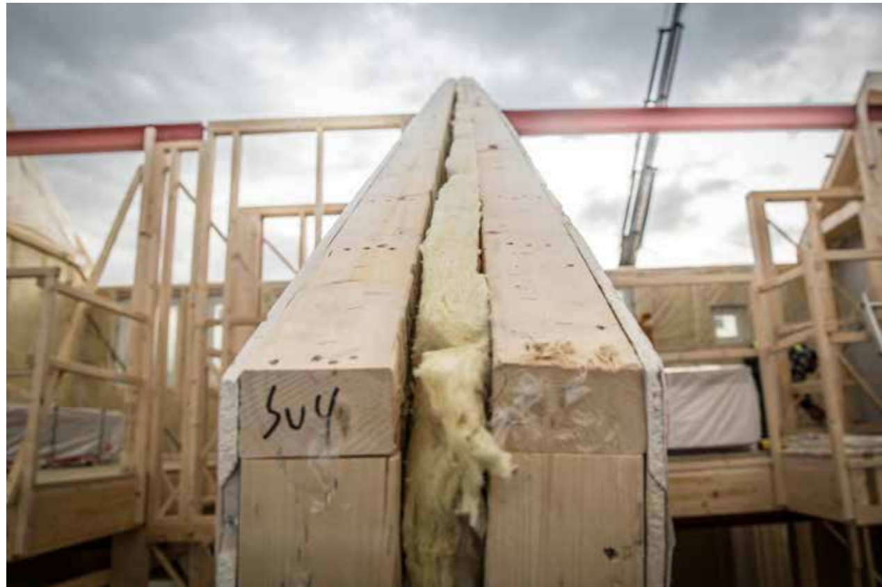
Isolasjon legges inn før motvegg monteres.
